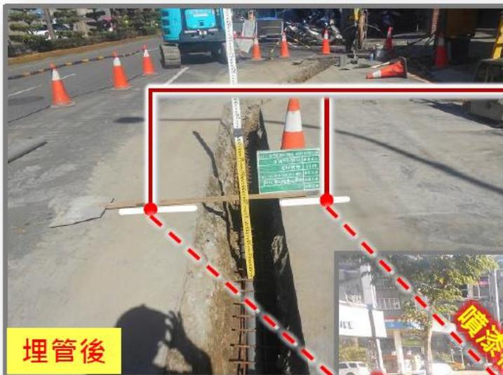
箱尺兩端須噴漆標定量測埋深之放置位置，並須避免回填覆蓋噴漆位置。
